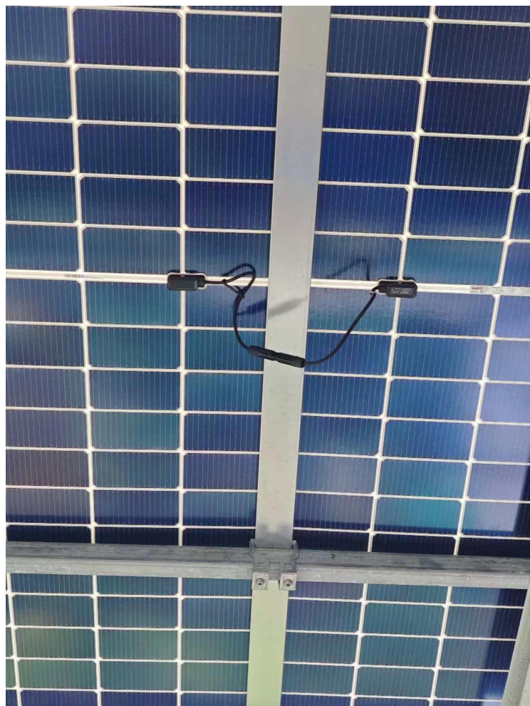
按照图纸设计将光伏组件正负极相接
